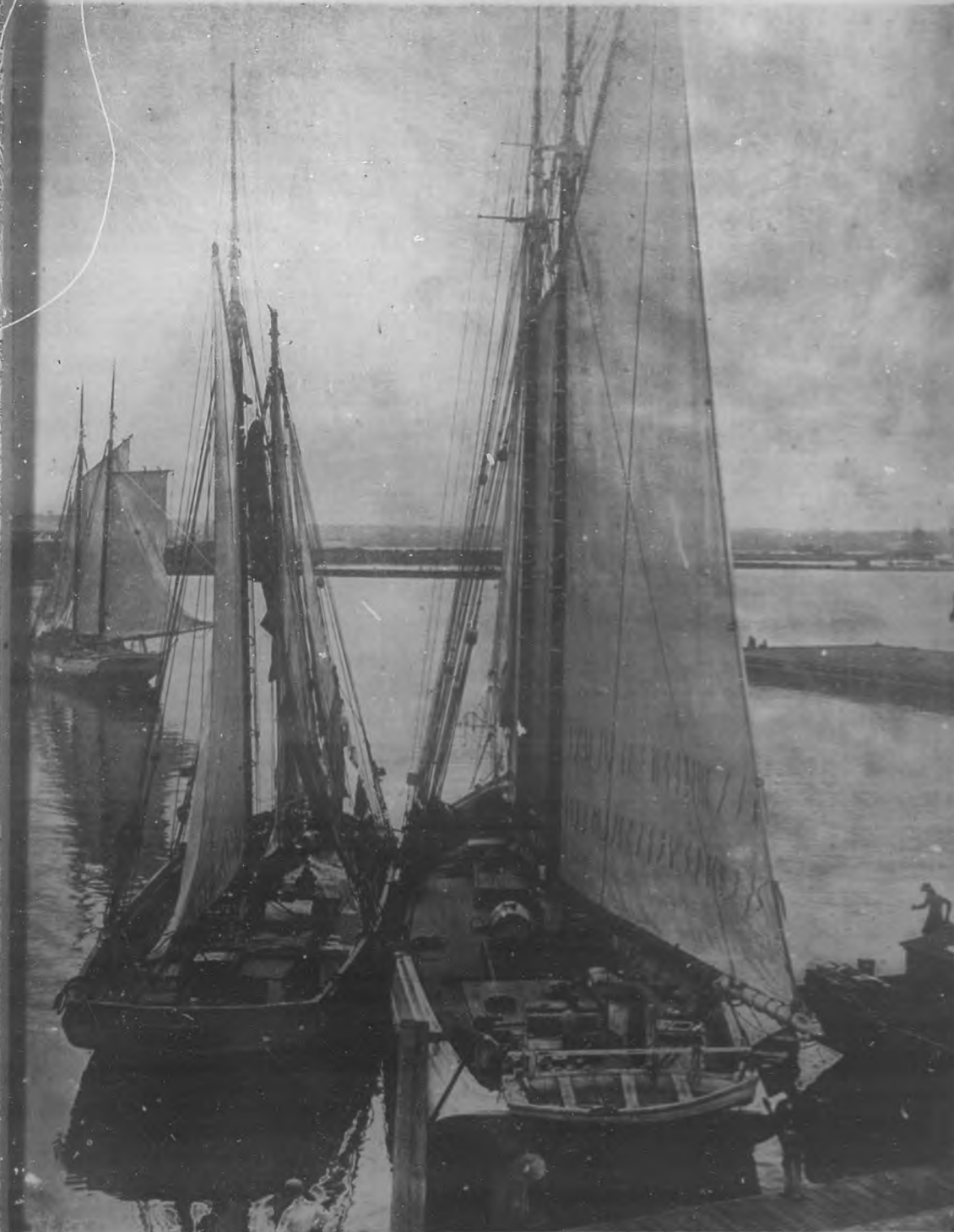
MUELLE DE TALLAPIEDRA.—(Habana).
